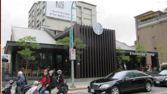
圖 4.48 內湖民權門市外觀與節能斜板屋頂
