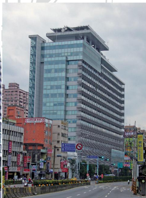
圖 3-3 捷運大坪林站現況
