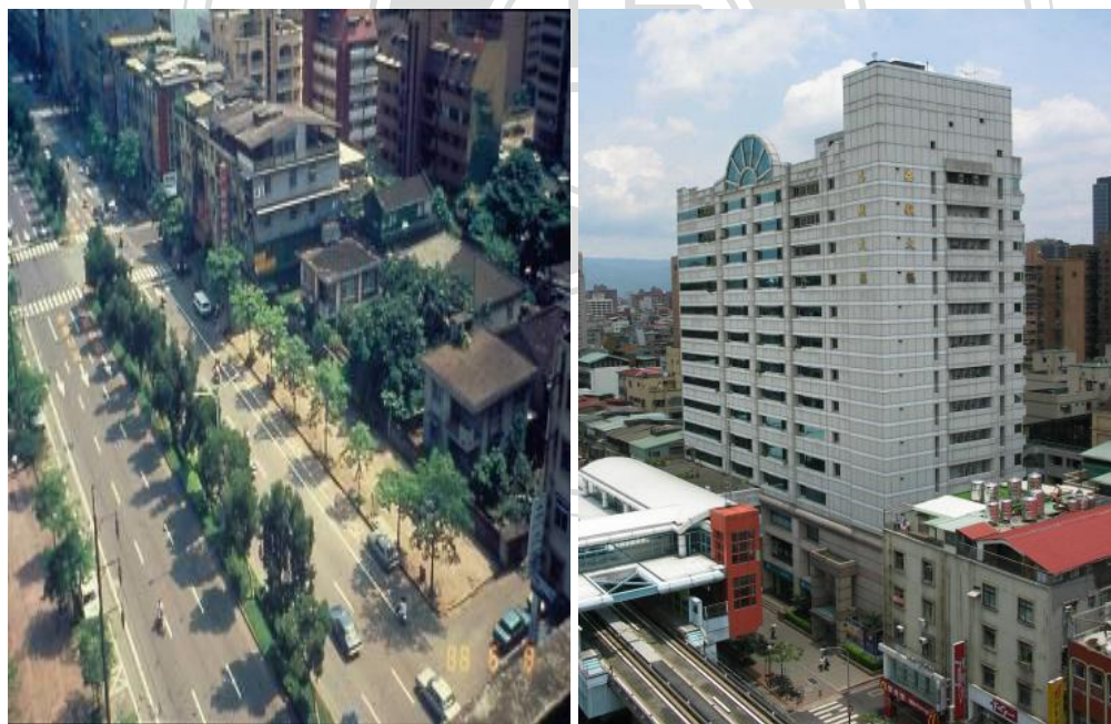
圖 3-1 科技大樓站聯開基地建物拆遷前之現場照片（左）、聯合開發大樓完工照片（右）
