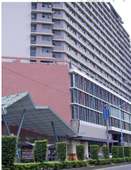
圖 3-2 捷運七張站現況圖
