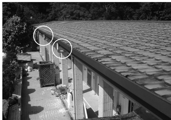
屋頂收集面排水管
